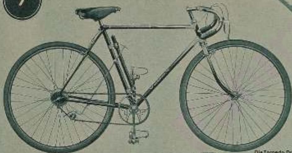
Die Torpedo Dreigangschaltung wird normalerweise mit einem dreifachen Aufsteckkranz mit 17 - 18 - 19 Zähnen geliefert
