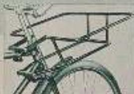
Dieser abnehmbare Vorderrad-Rohrgepäckträger kann mit allen WANDERER-Damen- und Herrenrädern gegen Bezahlung des Mehrpreises von RM 11,50 geliefert werden. Die Befestigung am Rahmen erfolgt durch Muffen.
