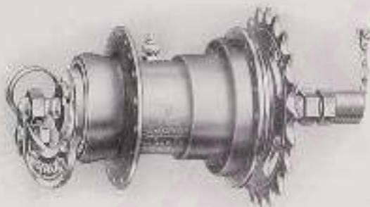
Torpedo-Freilaufnabe mit doppelter Übersetzung.
